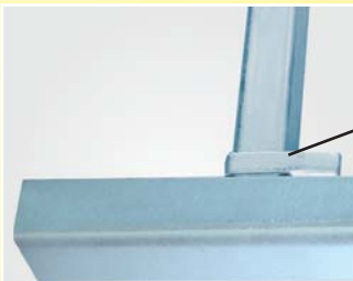
Variante 1: Befestigung beidseitig in Wandanschlussprofil
