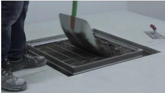
Legen Sie das Bewehrungsgitter in die Wanne, befüllen Sie die Wanne vollständig oder bis zur Unterkante des Endbodenbelags und betonieren Sie die Schachtabdeckung umlaufend vollständig oder bis zur Unterkante des Endbodenbelags ein. Achten Sie darauf, dass das Bewehrungsgitter vollständig mit Beton ummantelt ist und schützen Sie die Schrauben und Ränder vor Betonspritzern.
