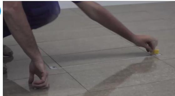
Reinigen Sie den restlichen Teil der Schachtabdeckung, schließen Sie sie und befestigen Sie die Schrauben und Abdeckkappen.
