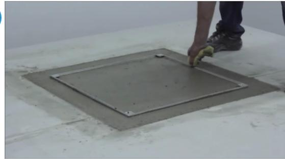
Lassen Sie den Beton vollständig aushärten. Sobald der Rahmen eine feste Verbindung mit dem Beton hat, kann die Schachtabdeckung nicht mehr verrutschen. Hat der Beton ca. 80 % seiner Festigkeit erreicht, reinigen Sie die sichtbaren Flächen der Schachtabdeckung.
